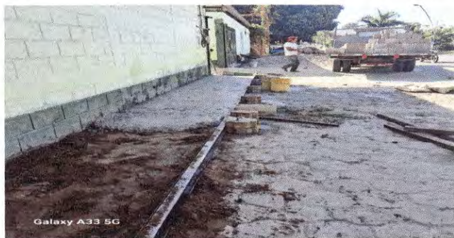
Foto 7 Piso: Reparación de banquetas de concreto, en entrada principal.
