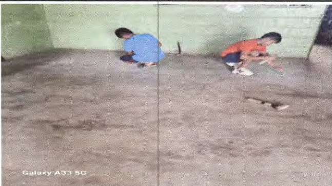
Foto 4: Piso: sustitución de piso de cemento liquido por piso cerámico en módulo 1 de aulas.
