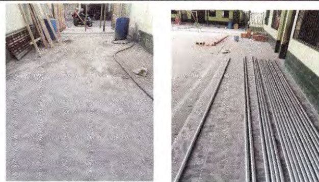
Foto 9 Piso: Reparación de plancha de concreto de patio, en módulo 1 de aulas.
