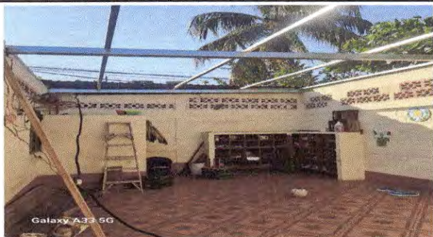
Foto 1 : Cubierta de lamina y estructura de techo: Sustitución de lamina troquelada y sustitución de estructura de soporte de metal, en el módulo 1 de aulas.
