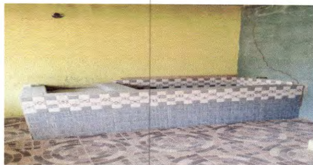
Foto 14: Reparación o sustitución de azulejos: Sustitución de azulejos en pila de la cocina
